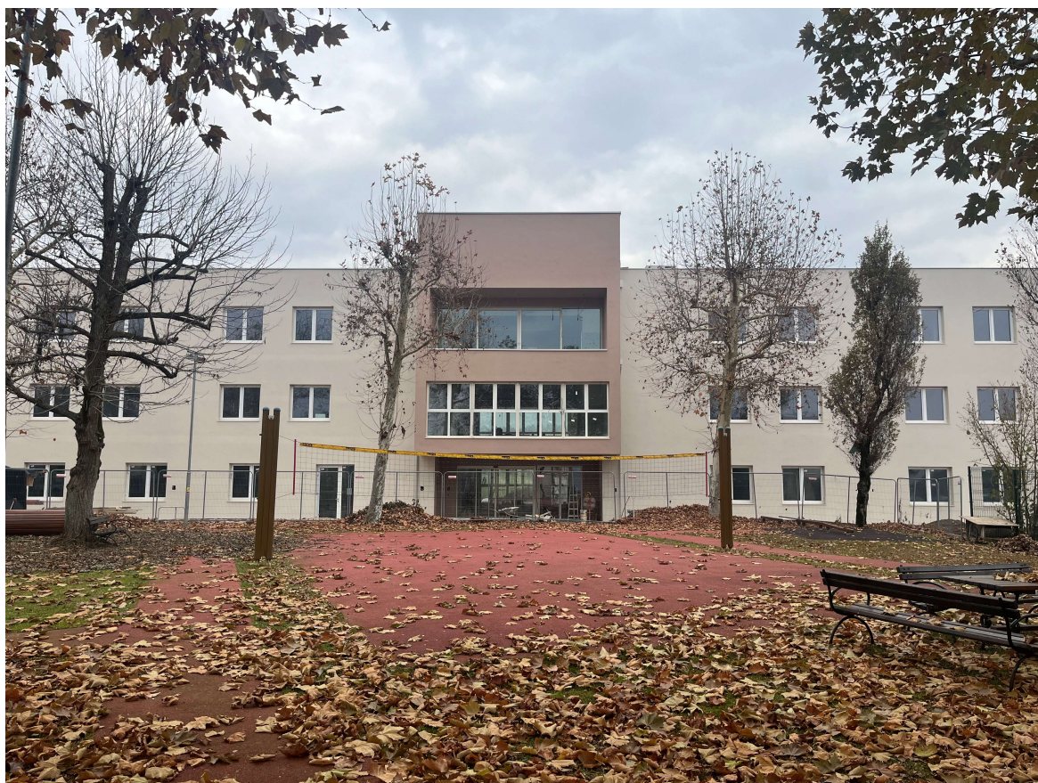
Slika 1: Fotografija novogradnje objekta D – južna stran
